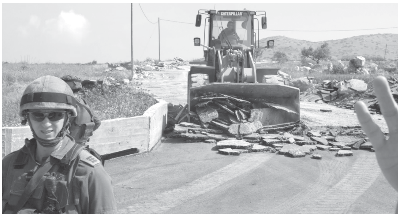
Demolición de una carretera en territorio palestino
