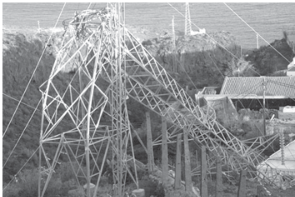
Torres eléctricas comidas por el óxido que cayeron como palillos con la tormenta tropical Delta.
