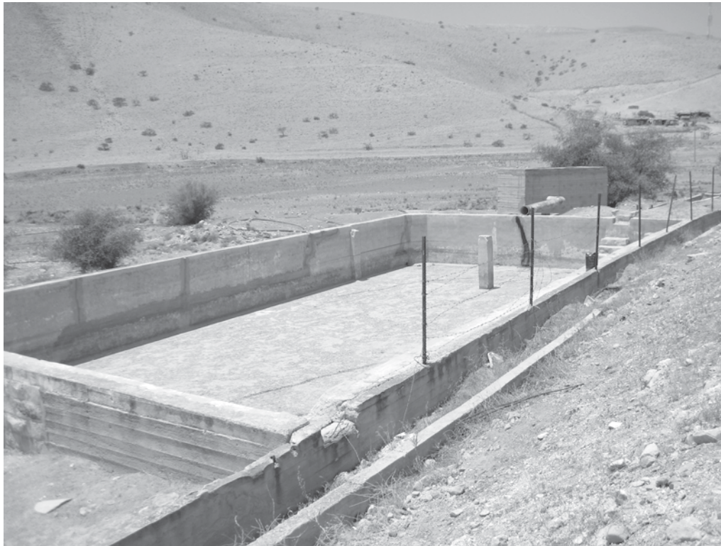
Depósito de agua vacío en Yiftlik (valle del Jordán).
