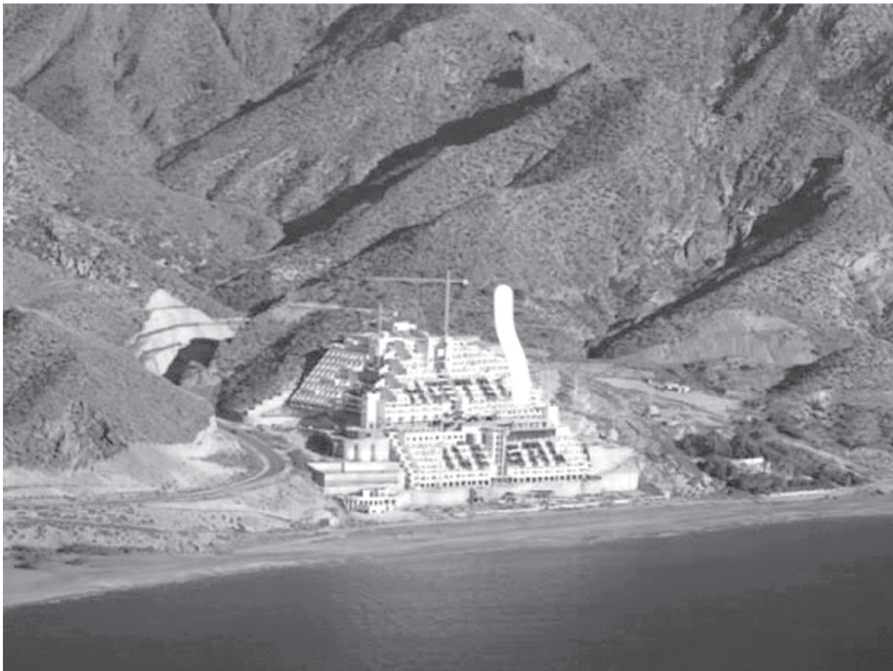
Hotel levantado en el Parque del Cabo de Gata (Almería) que vulnera la Ley de Costas.
