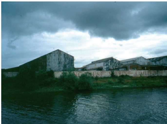
Glasgow: edificios abandonados a orillas del río Clyde.
