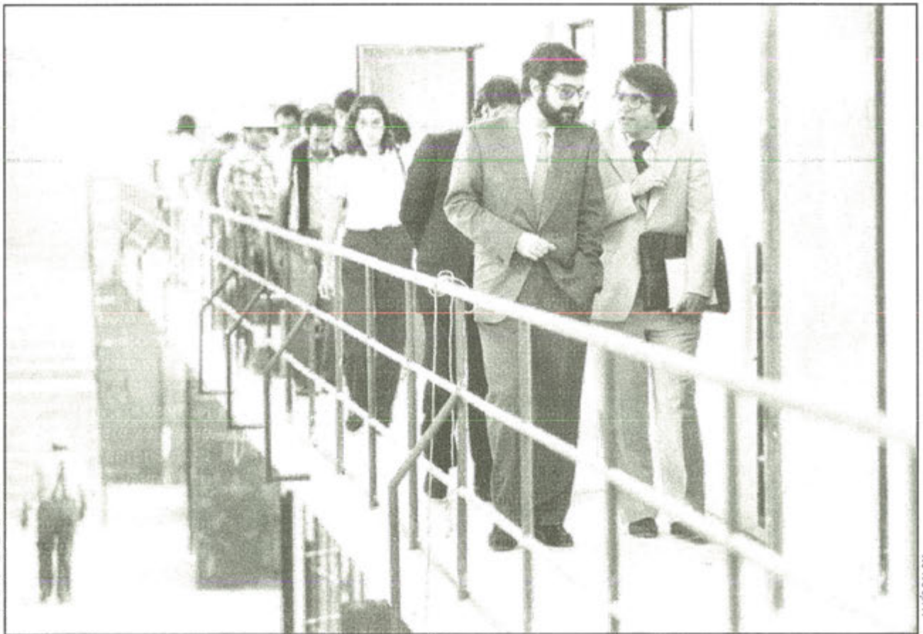
Ferrán Cardenal visitando las obras de la prisión de la Trinitat. Barcelona, 1983.
